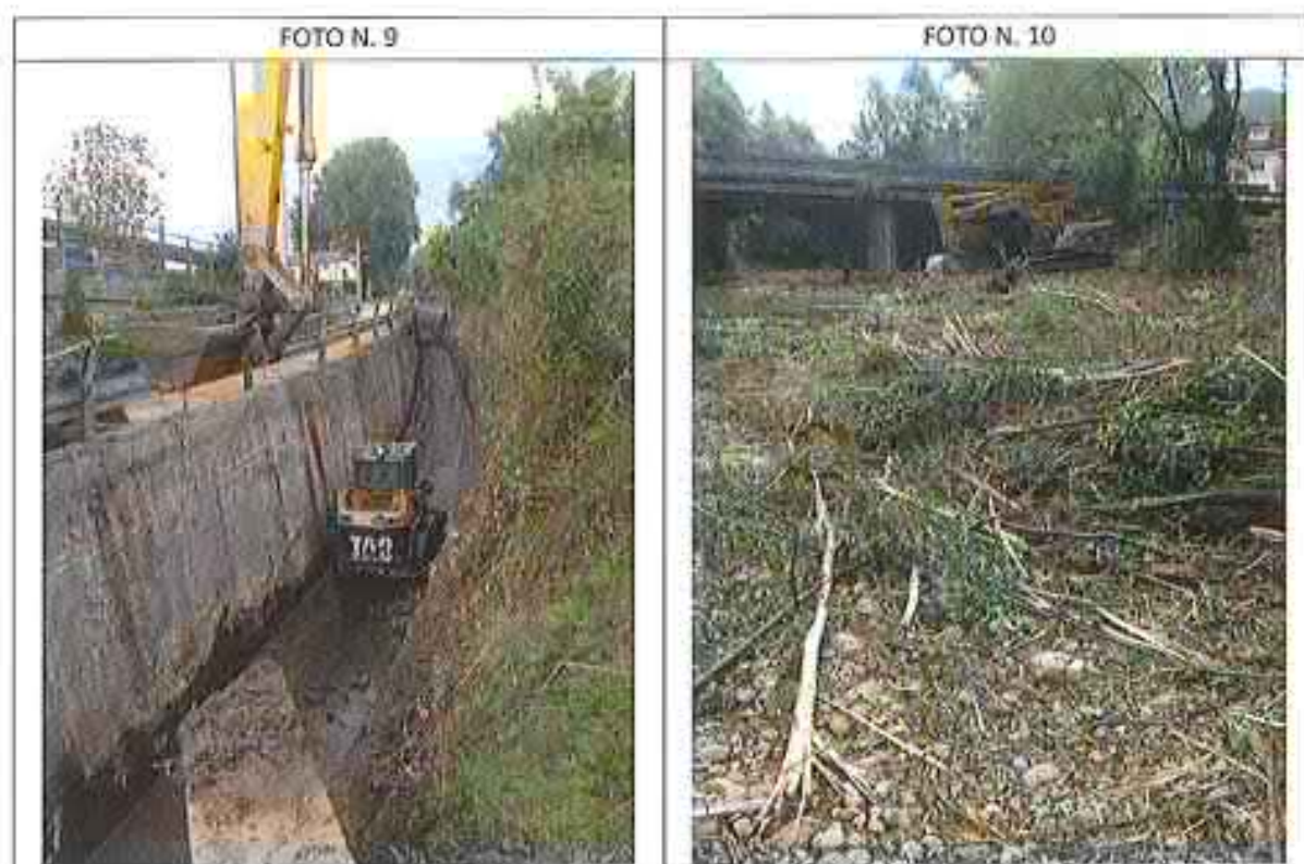
FOTO n.9 Espurgo sezione idraulica canale 22 in territorio di Aquino
