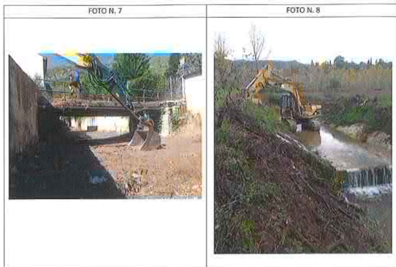
FOTO n.7 Decespugliamento ed espurgo sezione idraulica fosso S. Silvestro in Territorio di Cassino
