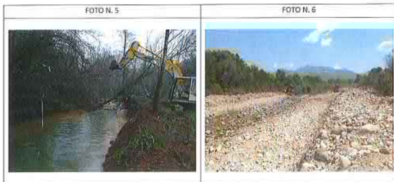
FOTO n.5 Riprofilatura sezione idraulica Forma Quesa in territorio di Pontecorvo
