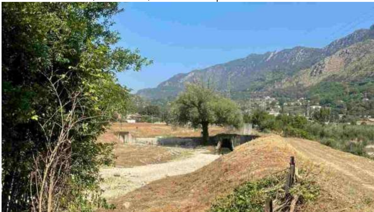
Lavori di bonifica presso il Rio Secco a Sant'Elia Fiumerapido
