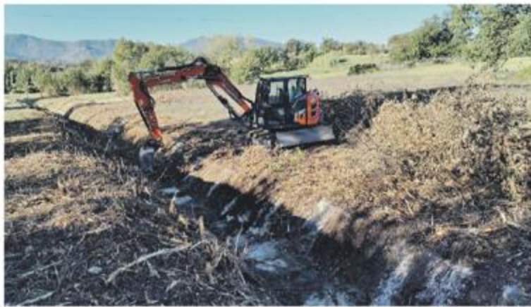
Uno dei lavori di manutenzione da parte del consorzio di Bonifica
